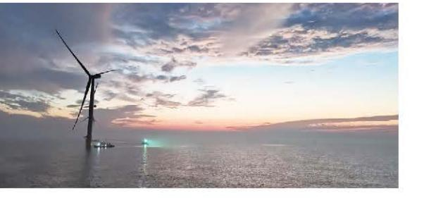
江苏如东800MW（H4#、H7#）海上风电项目规划建设200台4MW风电机组，建设2座220kV海上升压站和陆上集控中心。建成后风力发电机组产生的电力将通过35kV海底电缆收集线，送至220kV海上升压站35kV配电线。海上升压站升压至220kV后，通过两根220kV海底电缆送至陆上集控中心，最后到达电网系统。
